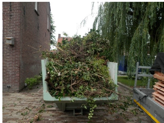
De nieuwe achterkant geplaatst
